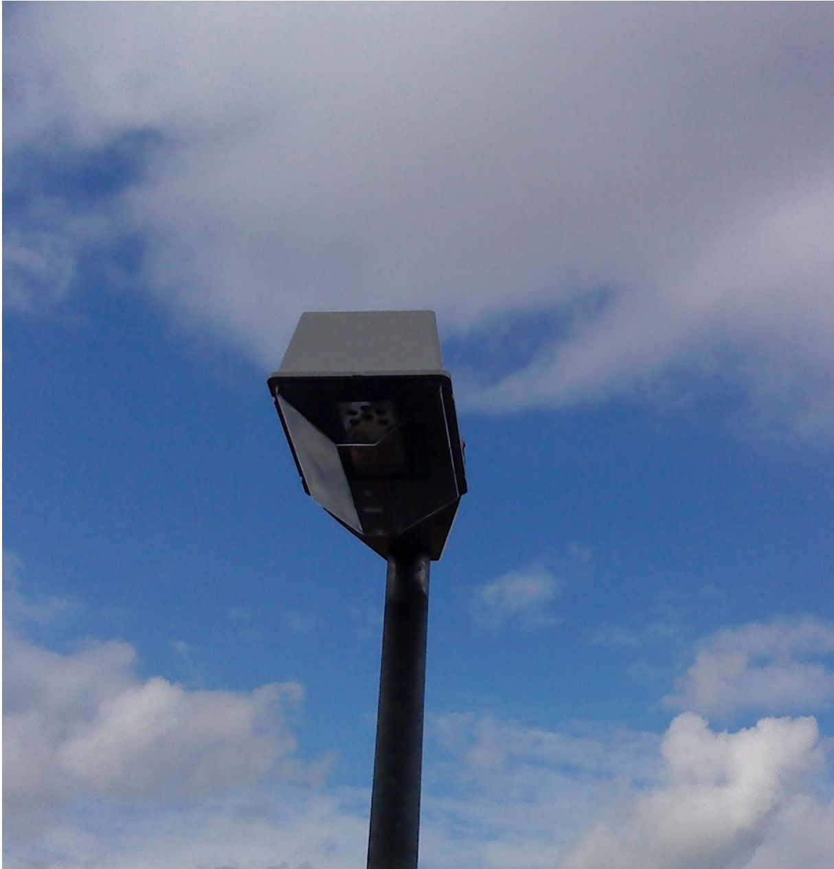
Abbildung 11: In Bergen zu Testzwecken dauerhaft installierter AUBELE-Prototyp
