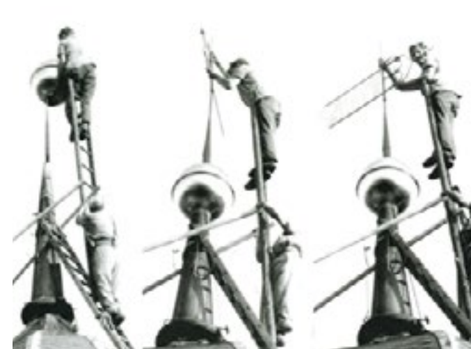
Bild 3: Ohne Gerüst stecken Paul Lis (unten) und sein Lehrling die Kugel auf die Turmspitze und befestigen die Wetterfahne.
