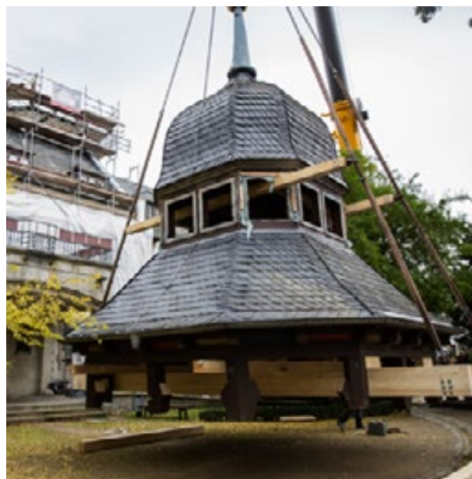
Bild 2: Der Turm steht vor der Rektoratsvilla, wo er saniert wird.
